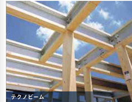
テクノビーム 木と鉄の複合梁「テクノビーム」を採用することで木造住宅の強度を強化しています。
